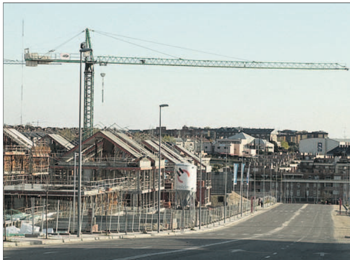
Una promoción de viviendas en construcción en Madrid. PABLO MONGE.
